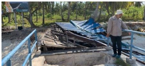
Peninjauan kondisi GeositePulau Senua pasca musim utara (gelombang tinggi)
