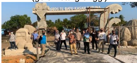
Peninjauan pekerjaan pembangunan gerbang Geosite Batu Kasah bersama perwakilan WNC (Premier Oil Indonesia, Medco Energi& Star Energi)
